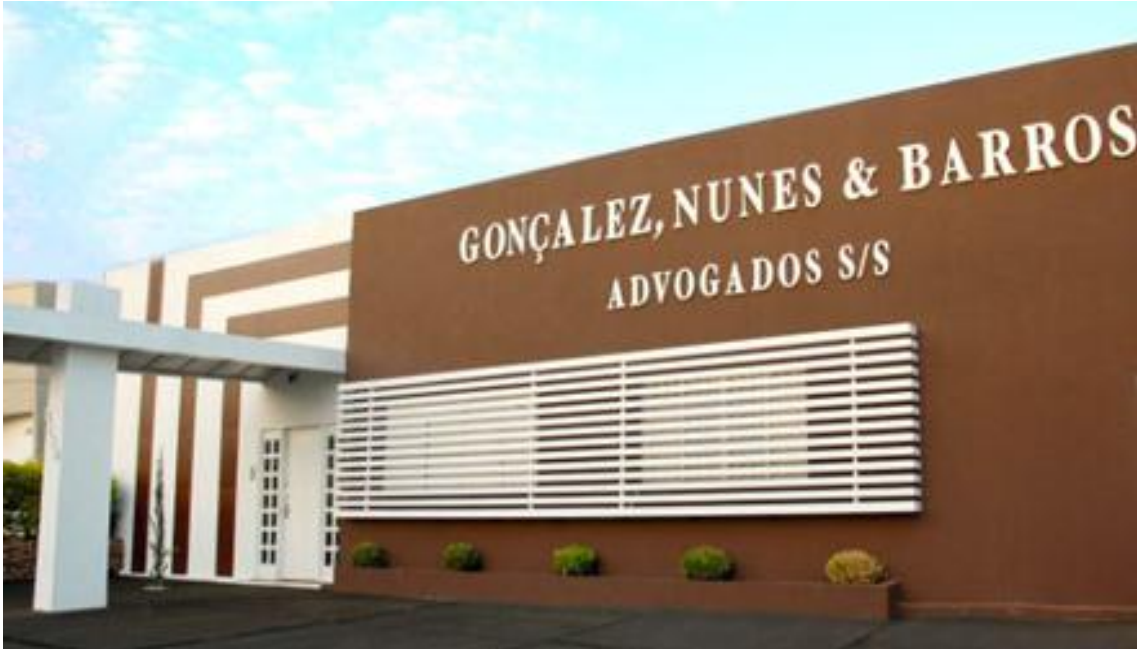
Figura01: Foto da Fachada
